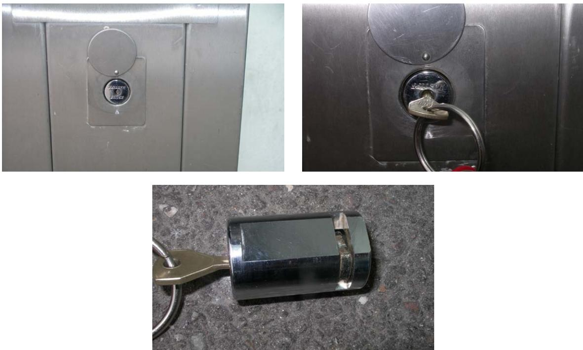
Bild 27, 28 und 29: Herausnehmen des Stahlzylinders beim genormten FSE
