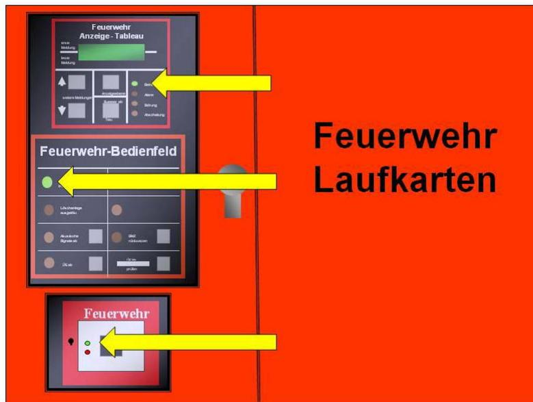
Bild 23: So sollte die FIZ bei Verlassen des Objektes aussehen
