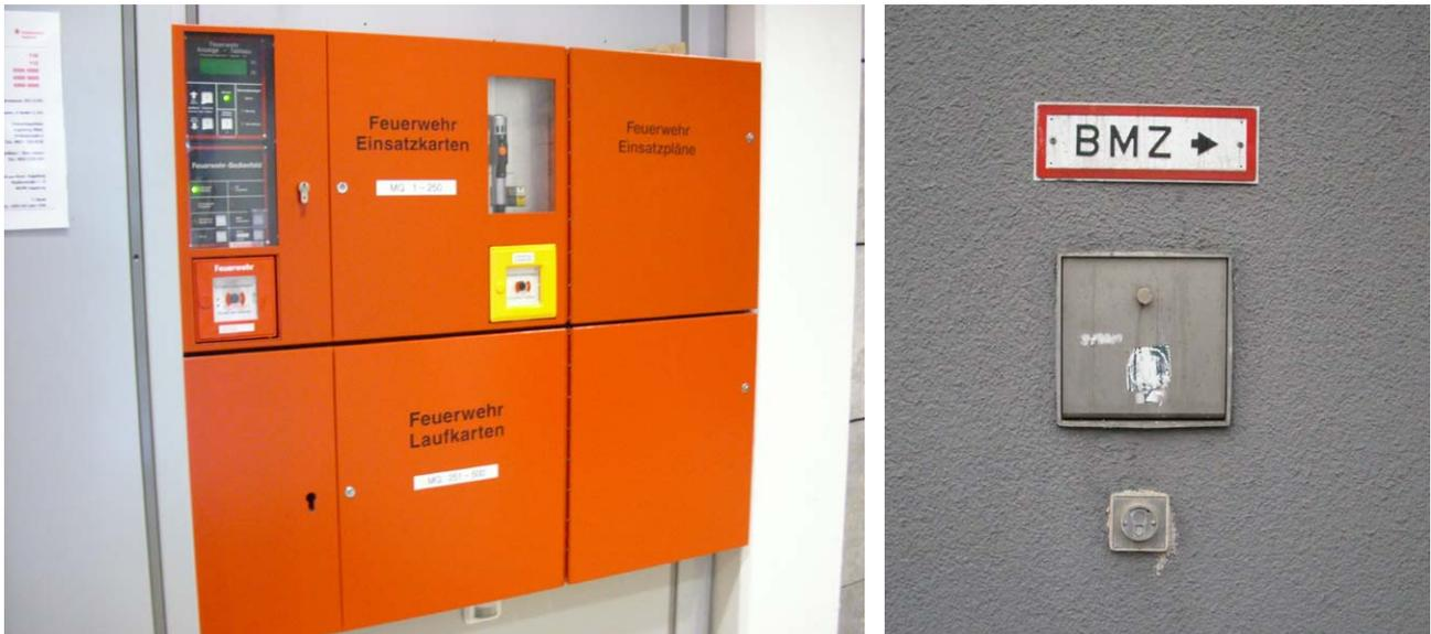
Bild 8: Eingebautes Feuerwehrschränke mit Freischaltetelefon und Hinweisschild sowie Feuerwehreinrichtungsstation wie man sie vorfindet
